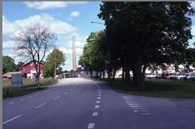
Bebyggelse på ömse sidor om Kungsleden – bruket och brukshandeln. Foto från 1988.
