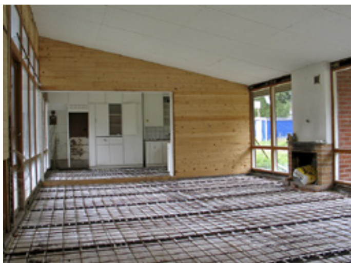
Ny isolering och golvvärme före övergjutning. Bild från originallägenheten i juni 2006.
