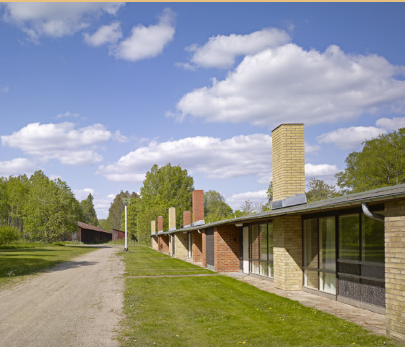
Den långa fasaden mot Holsteins väg har varierats med hjälp av tegel i två olika kulörer. Foto: Bert Leandersson.
