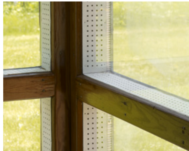
Vid renoveringen sparades två ursprungliga rutor i det sydöstra hörnet av originallägenhetens stora sovrum. Rutorna syns till höger i bild. De känns igen på det karaktäristiska veckade aluminiumbandet. Foto: Bert Leandersson.
