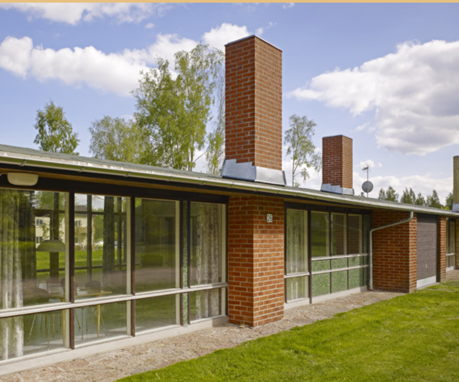
Skorstenarnas övre del murades om 2006-2007. Samma del hade förnyats vid en renovering omkring 1970, då man även lade sinuskorrugerade eternitskivor på taken. Foto: Bert Leandersson.
