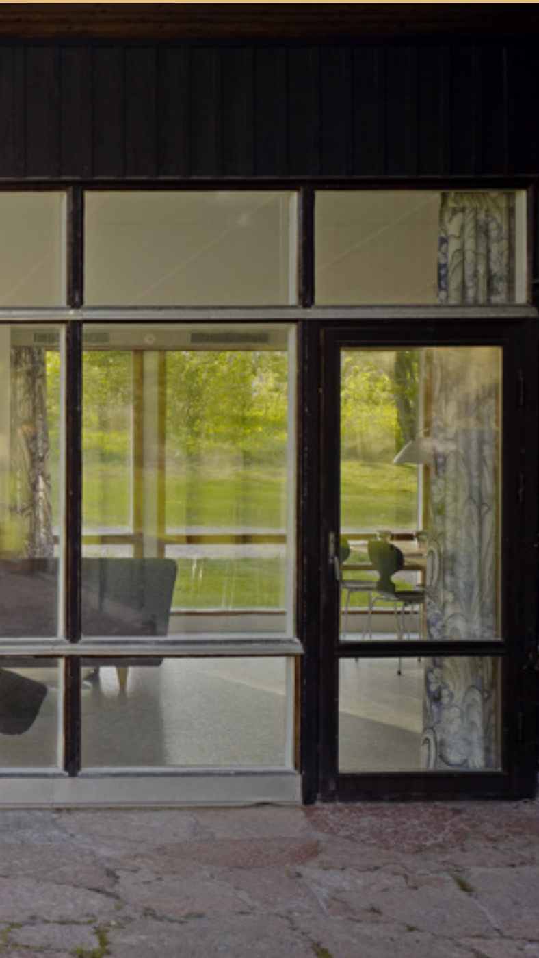
Vid renoveringen sparades två ursprungliga rutor i det sydöstra hörnet av originallägenhetens stora sovrum. Rutorna syns till höger i bild. De känns igen på det karaktäristiska veckade aluminiumbandet. Foto: Bert Leandersson.
