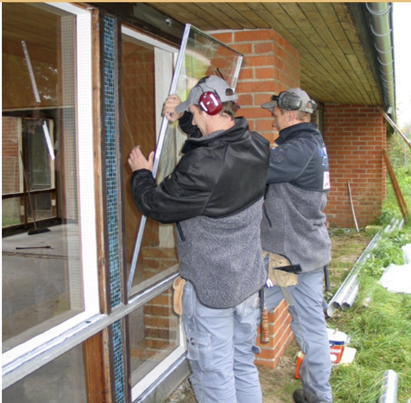
I samband med renoveringen 2006-2007 blev det nödvändigt att byta ut Bruno Mathssons ursprungliga isolerrutor. Många var krossade och resten hade fått en vit beläggning mellan glaset. Här monteras en ny isolerruta av snickare från John Svenssons Byggnadsfirma i Lessebo. Foto: Jan Westergren, Kalmar läns museum.
