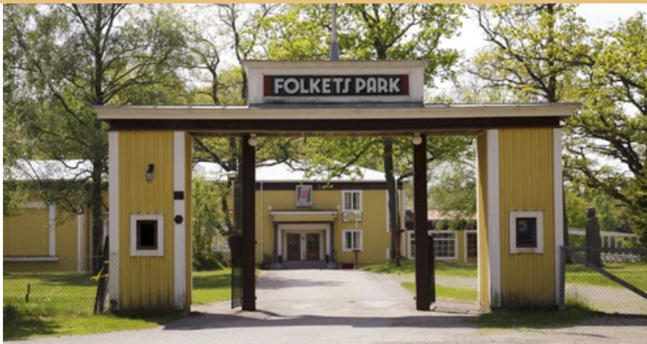
Folkets Hus och park i Norrhult är byggnadsminne sedan 1999. Foto: Jörgen Ludvigsson, Kulturparken Småland AB.
