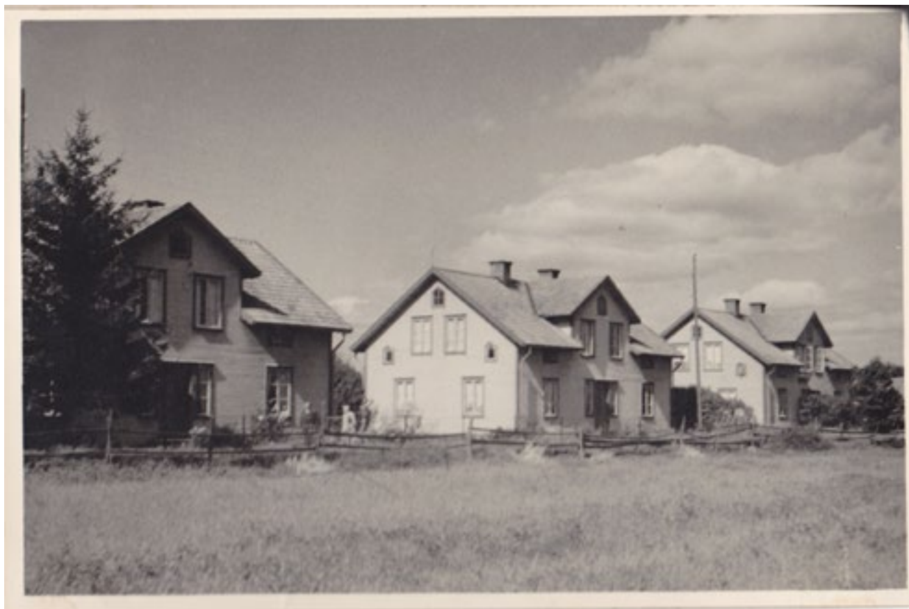
Tyskabyggningarna var de första arbetarbostäderna som byggdes på Rosdala Glasbruk. Bilden är troligen tagen på 1920-30-talet. Källa: Rosdala glasbruks arkiv
