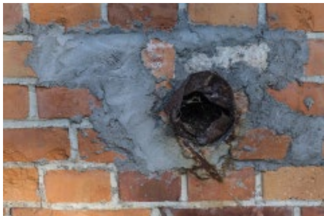
Detalj på fasad i ångmaskinshus.
