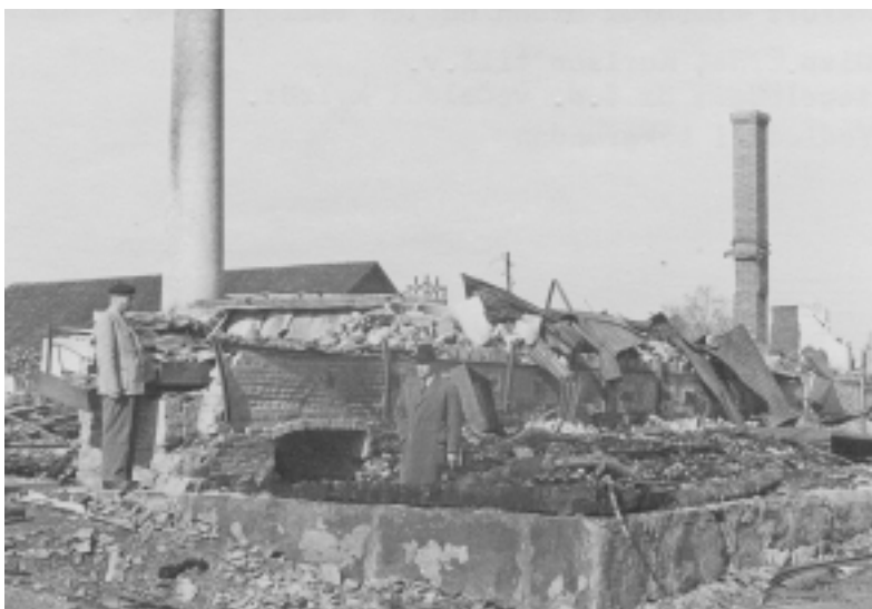
Efter branden - Ernst Karlson mitt i förödelsen efter branden. Arkivbilder från Ljuders hem- bygdsförenings arkiv.
