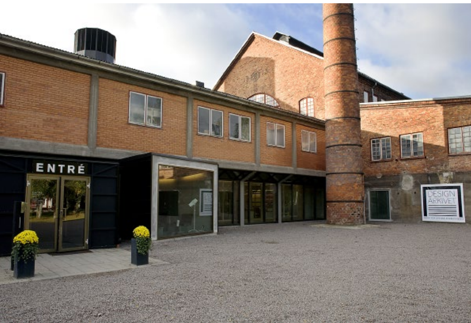
Skorsten och entrébyggnad intill konserthyttan och Designarkivet. Foto: Eva Wågnelin, Designarkivet, Pukeberg
