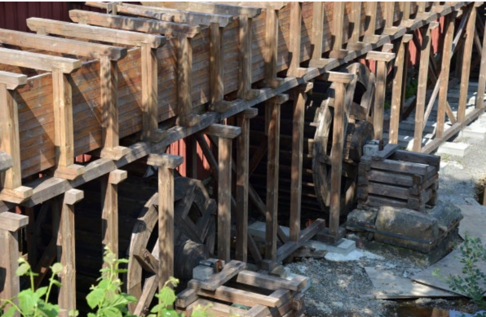
Hammarsmedjans rekonstruerade vattenränna.
