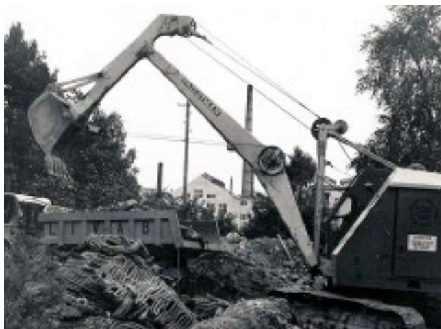
Villabygge under tidigt 1960-tal. Glasbruket skymtar i bakgrunden.
