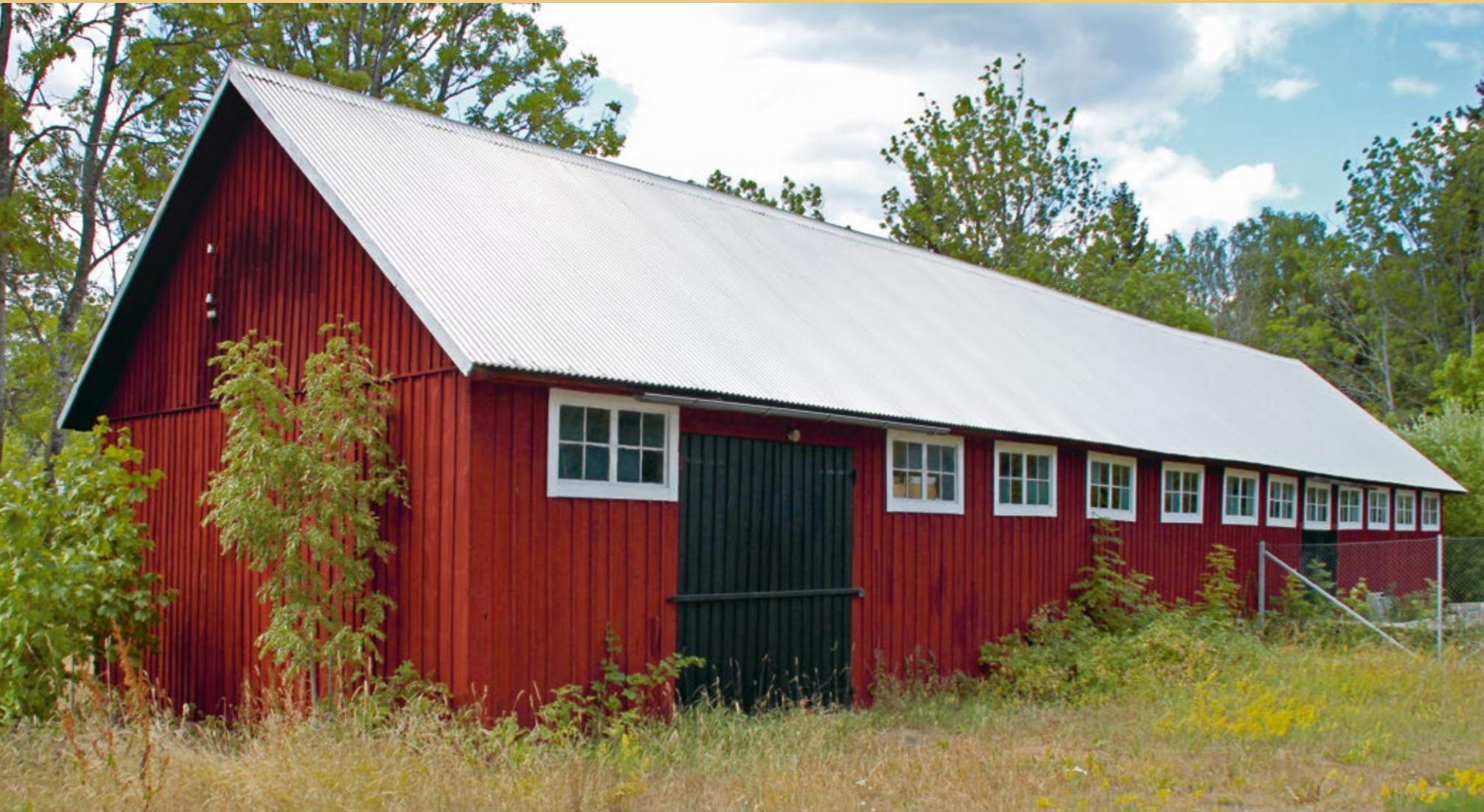
Magasinsbyggnaden. Foto: Lotta Lamke, Länsstyrelsen Kalmar län.
