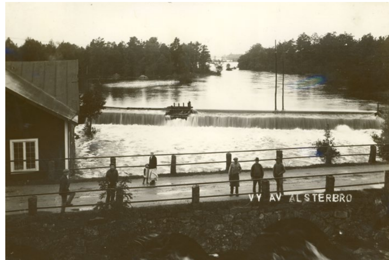
Stenvalvsbron över Alsterån 1928. I bakgrunden ses dammanläggningen med skibordet.
