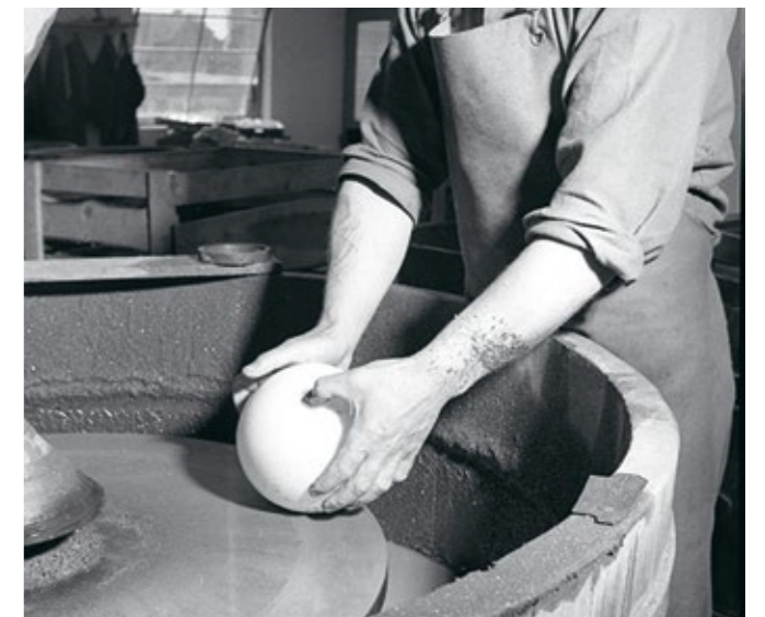
Slipning av lampglas.
