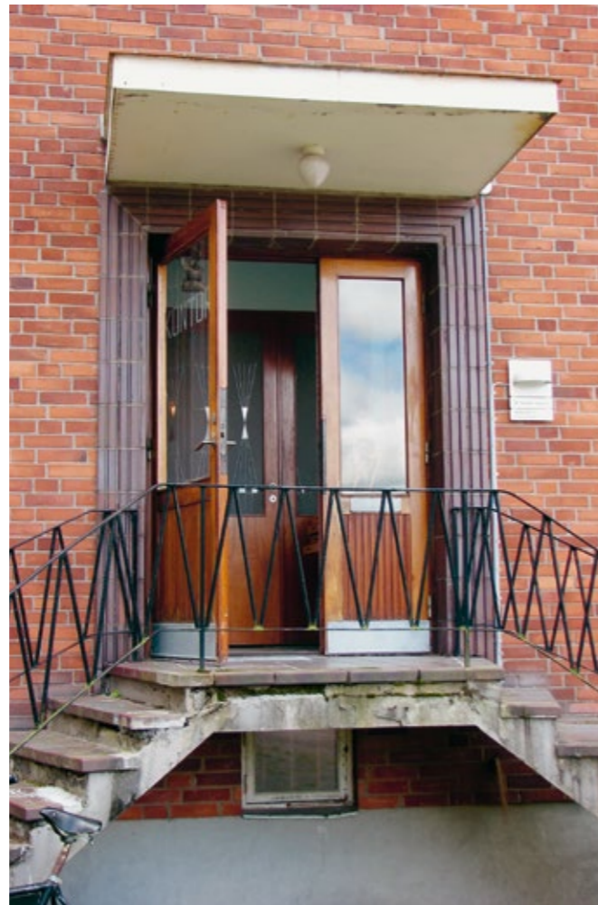
Kontorets entré med typiska originaldetaljer från 1957.
