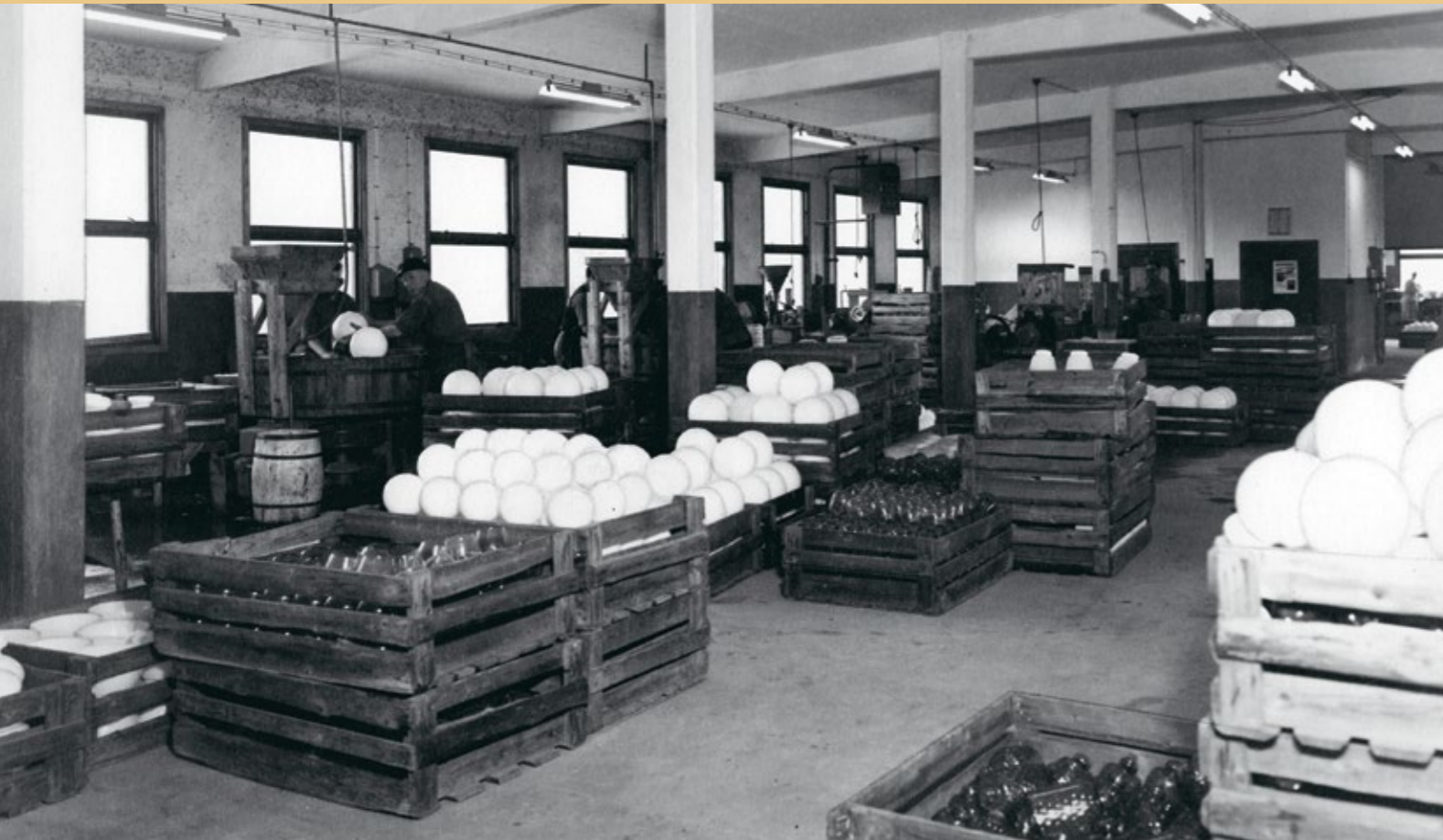
Bild från det på 1950-talet nybyggda sliperiet. I några av de snickrade lådorna ligger de klassiska vita lampgloberna som var en av de armaturer som tillverkades på Rosdala.
