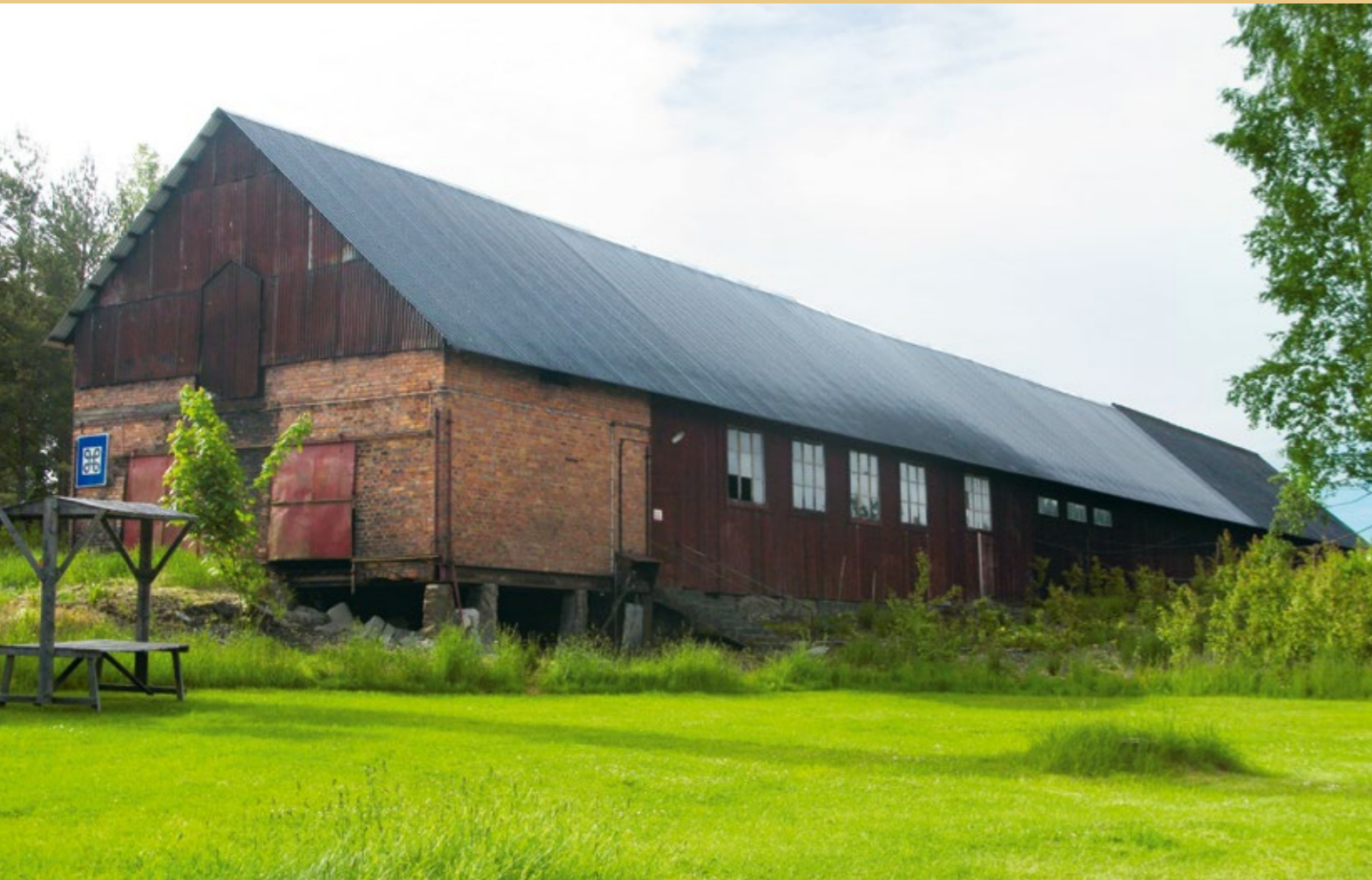
Gamla torvladan där bränsle till ugnarna förvarades. I utrymmet till vänster i bild finns de gamla gasugnarna kvar.
