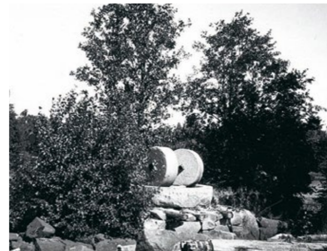
Den gamla kollergången eller krossen som användes för att krossa kisel (kvars) och deglar vid det första glas bruket som låg här. Idag ligger den kvar under vattnet i dammen.
