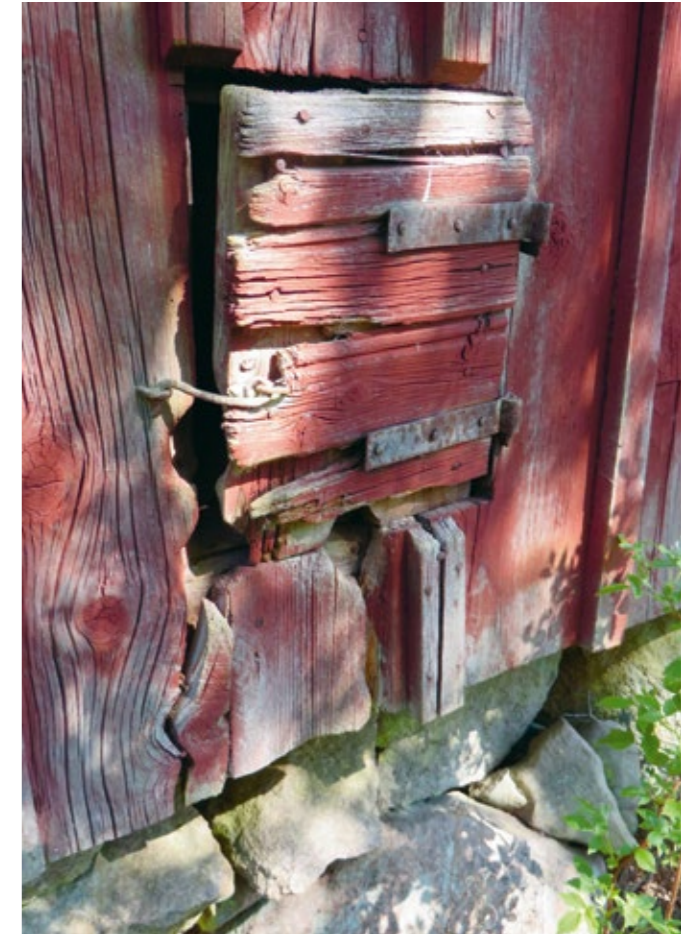
Detaljer från den vackra hönshusbyggnaden.
