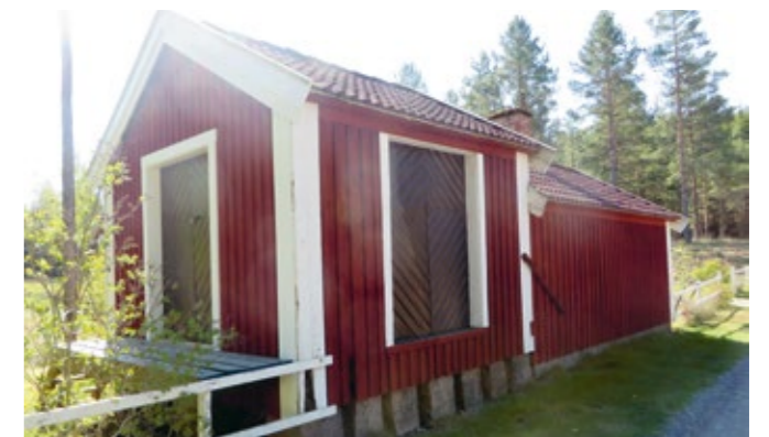
Stationsmiljön Rydefors, som ligger en bit ifrån bruket hade stor betydelse för brukets leveranser av sand och andra råvaror under de 40 år då järnvägen fanns mellan 1923 och 1963.
