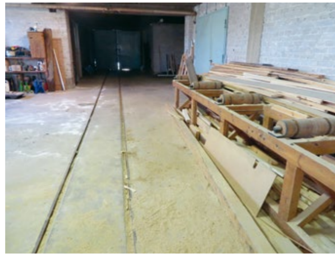
Rester av räls finns kvar inne i en av byggnaderna.
