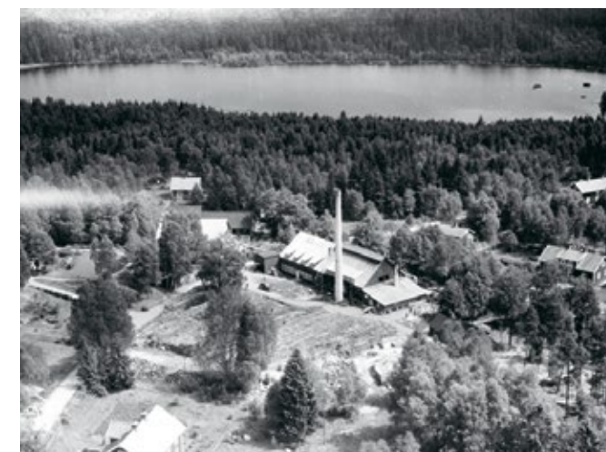
Flygbilden över samhället och hyttan visar den enormt stora planen framför hyttan fylld med vedtravar. Nere till vänster i bild Mästarbo. Till höger i bild de båda arbetarbostäderna Backabo och Åbo. (Foto: Smålands museum.)
