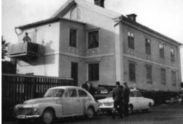
Tv. Torghandeln i dag. Th. Bolanderska huset under rullning från torget till ny grund vid Grönvägen. På balkongen ägaren Enoch Nyvall.
