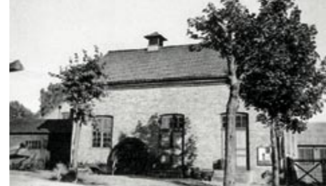
Kraftcentralen på 1920-talet, innan den byggdes ut.
