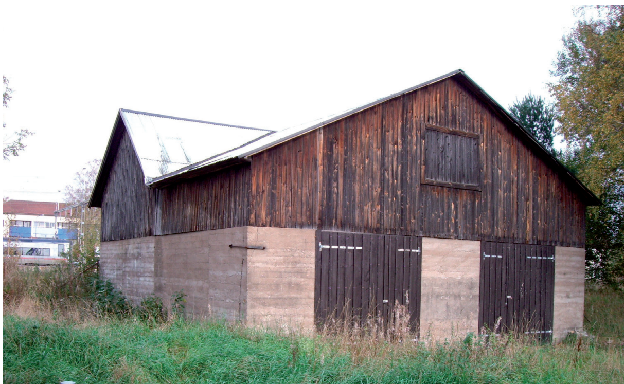
Figur 16. Vid järnvägen i Emmaboda hade Åfors glasbruk sitt magasin, 1,5 mil från bruksorten. Här förvarades sand och andra råvaror samt det färdiga glaset. Magasinet visar på glasbrukens påverkan på omlandet.
