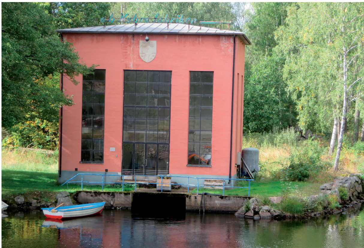
Figur 32. En av alla kraftstationer i Glasriket som nyttjade vattnets kraft för att driva glasbrukets slipermaskiner, men också för att ge ström till hela bruksorten. Alsterfors.
