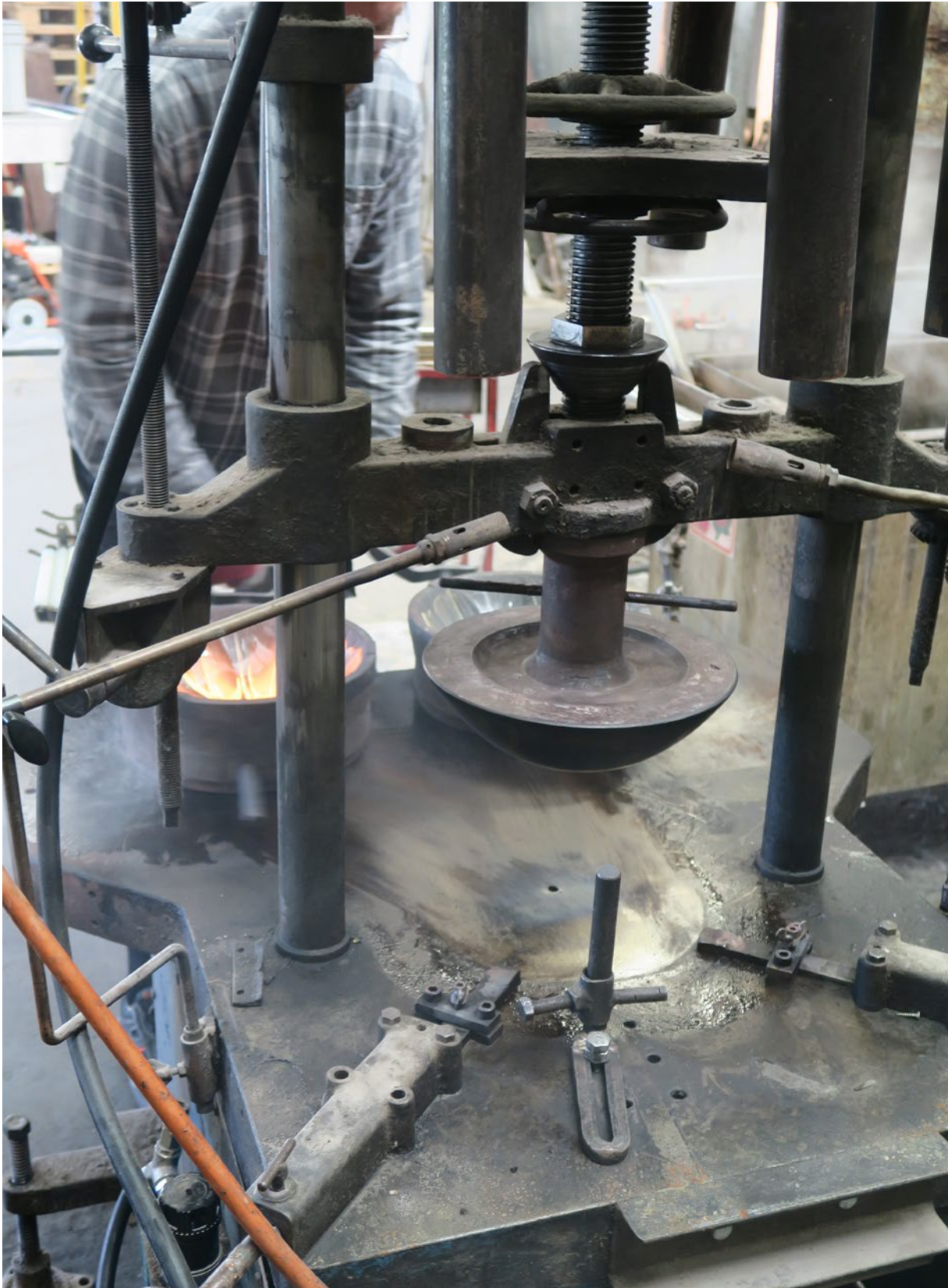
Här syns de två styrblecken som är förankrade i pressbordet.
